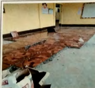
Foto 6: MODULO B aula lateral izquierda se instaló piso cerámico sobre base de cemento líquido.
