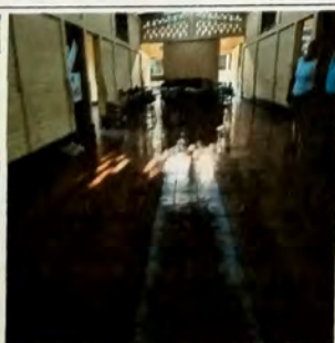
Foto 5: MODULO corredor central se instaló piso cerámico sobre base de cemento líquido.
