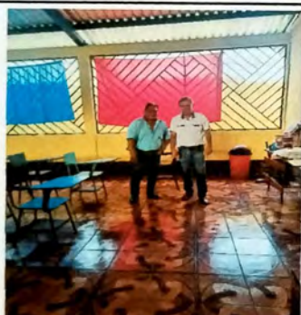
Foto 9: Vista de aula anexa a direccion, se instal piso ceramico sobre base de concreto.
