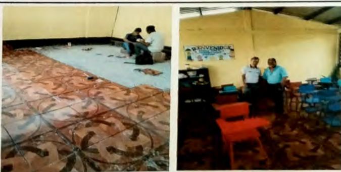
Foto 12: Vista de aula anexa a direccion, se instal piso ceramico sobre base de concreto.
