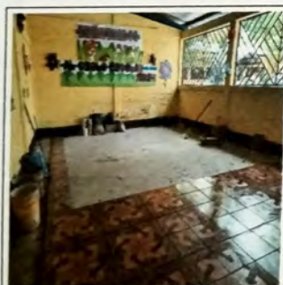
Foto 3: MODULO B aula lateral derecha se instaló piso cerámico sobre base de cemento líquido.
