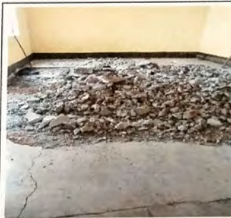
Foto 4: MODULO B aula lateral derecha se instaló piso cerámico sobre base de cemento líquido.
