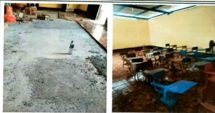
Foto 8: Vista de aula anexa a direccion, se instal piso ceramico sobre base de concreto.
