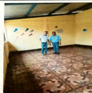
Foto 4: MODULO B aula lateral derecha se instaló piso cerámico sobre base de cemento líquido.
