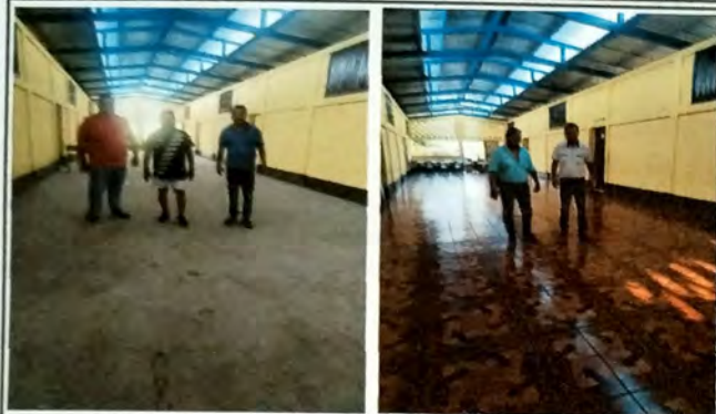
Foto7: MODULO B vista de corredor central se instalo piso ceramico sobre base de cemento liquido.
