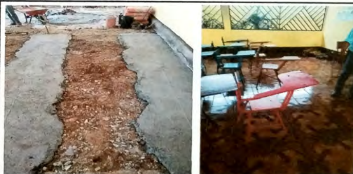
Foto 10: Vista de aula anexa a direccion, se instal piso ceramico sobre base de concreto.
