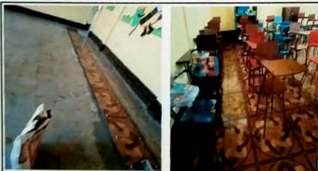
Foto 11: Vista de aula anexa a direccion, se instal piso ceramico sobre base de concreto.
